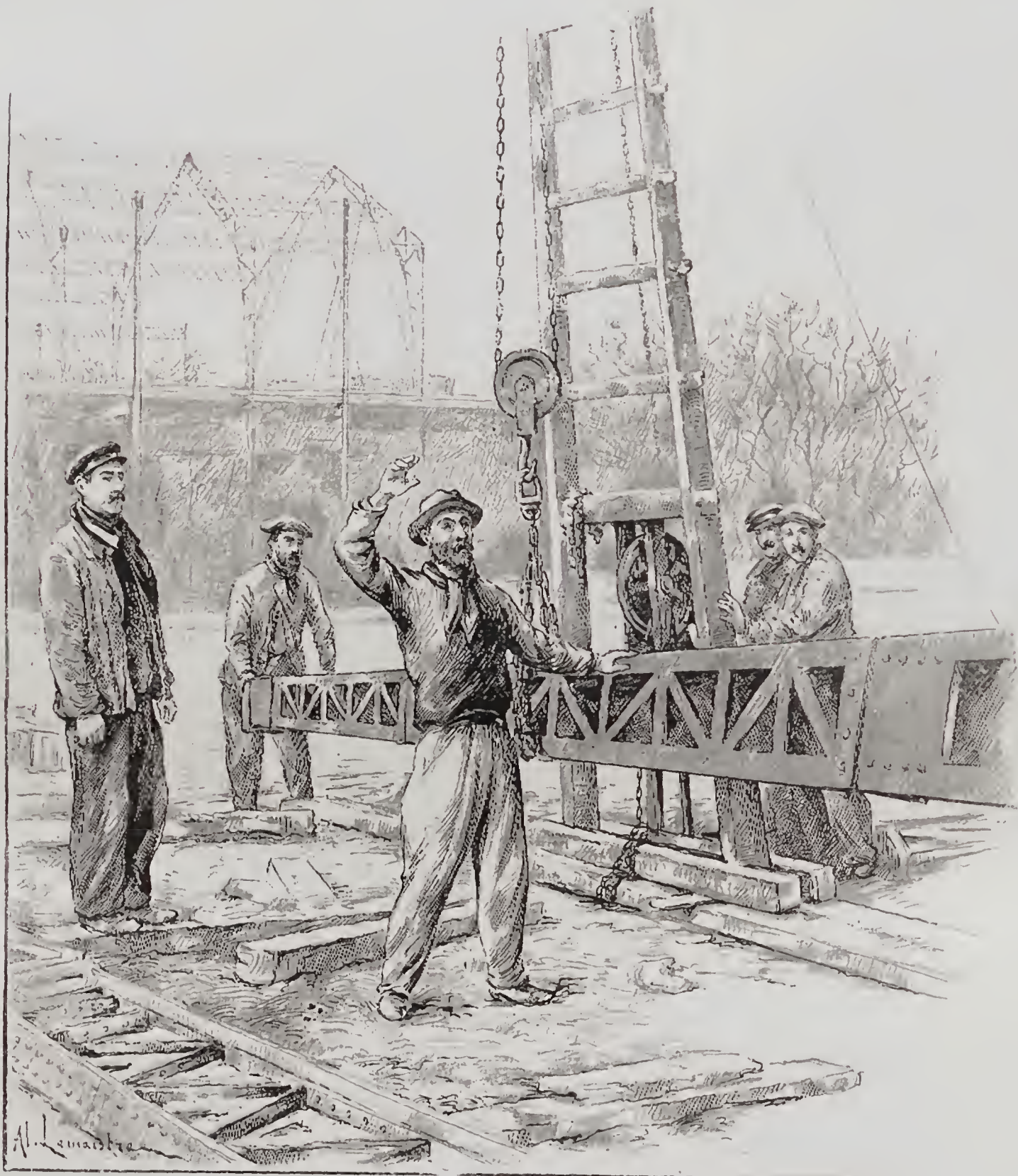
SUR LES CHANTIERS. — La manœuvre de la chèvre (Esplanade des Invalides).
